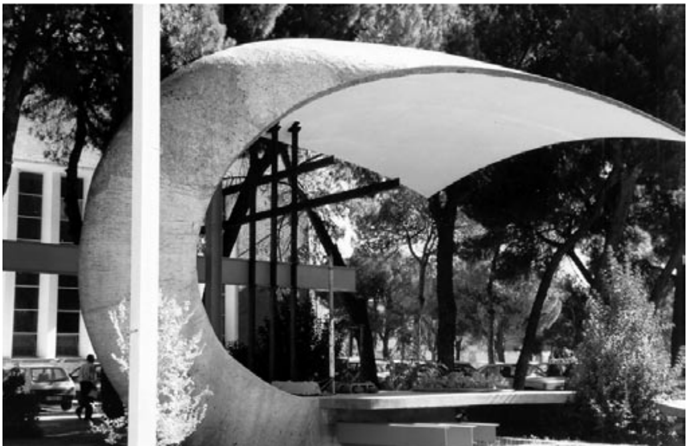
Fig. 2.- Lámina de hormigón pretensado denominada "el elefante" en el patio de Alarifes del Torroja
